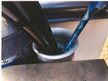
▲施工後約24時間で固着
